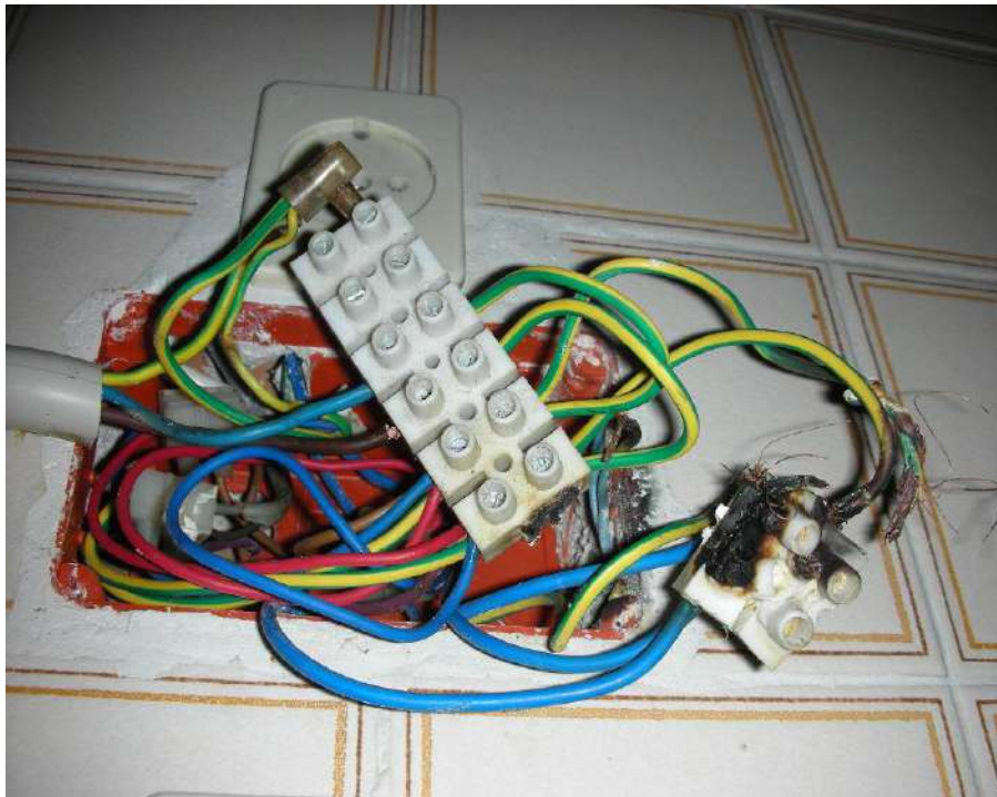
Guasto da sovraccarico elettrico
